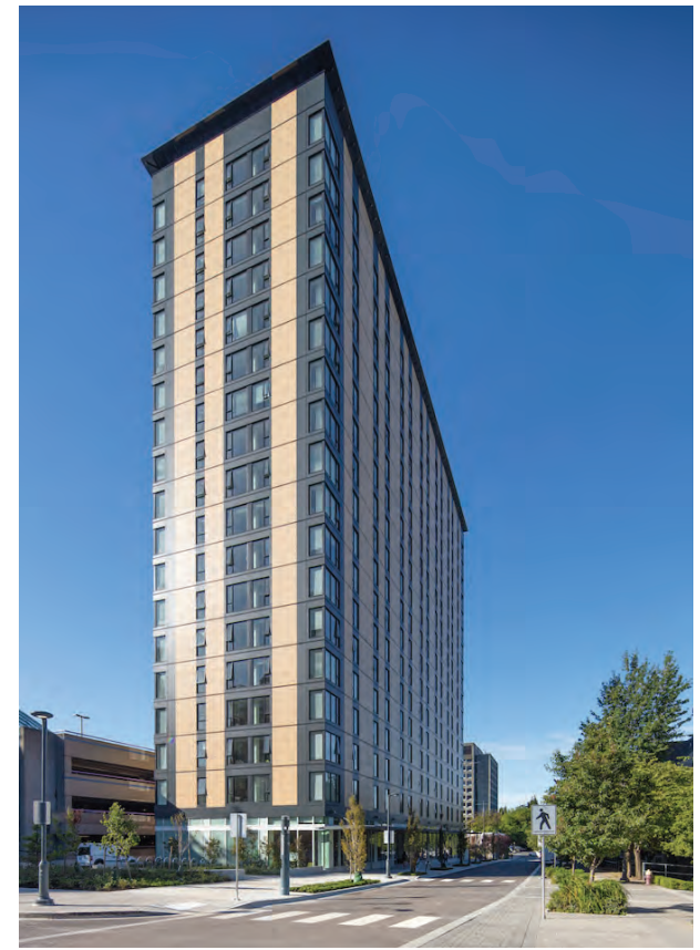
BROCK COMMONS - VANCOUVER
